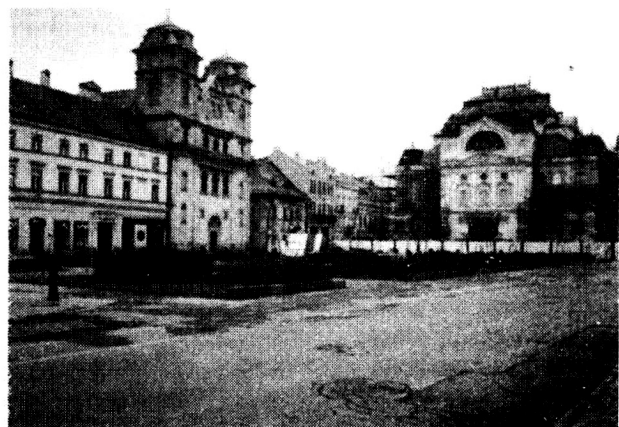
Pohľad na budovu Štátneho divadla v Košiciach, oplotenú počas dostavby a rekonštrukčných prác
