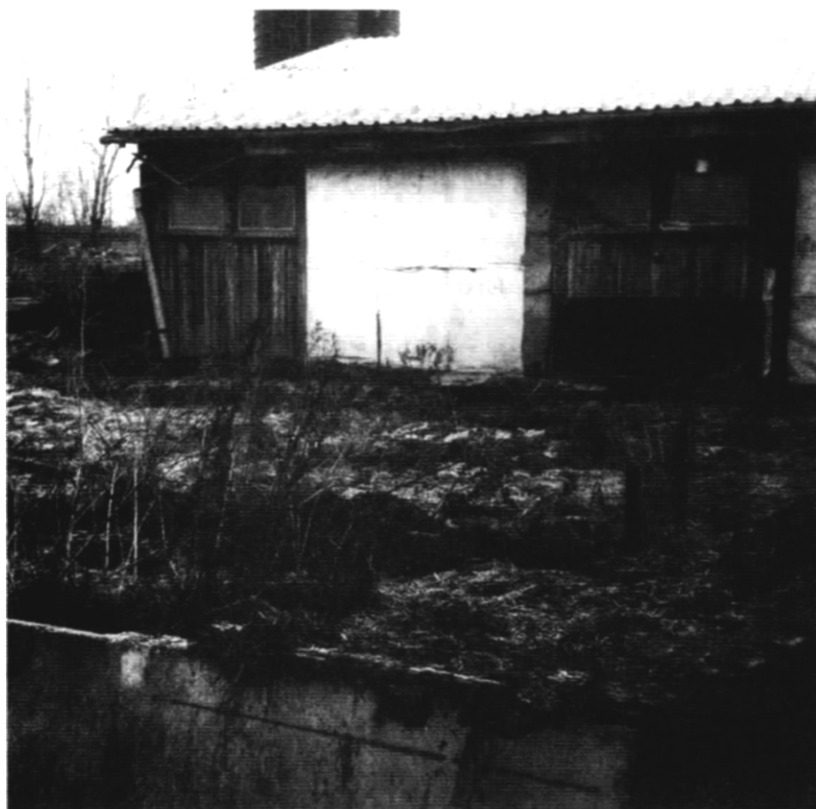
Zberná nádrž tekutých výkalov pred maštaľou na ustajnenie prasníc, ktorá sa môže po poškodení betónovej izolácie stať zdrojom kontaminácie pôdy a spodných vôd. Pri čerpaní výkalov zo zbernej nádrže sa koncentrácia čpavku a sírovodíka v okolitom prostredí dočasne zvyšuje a môže ohroziť zdravie človeka.
