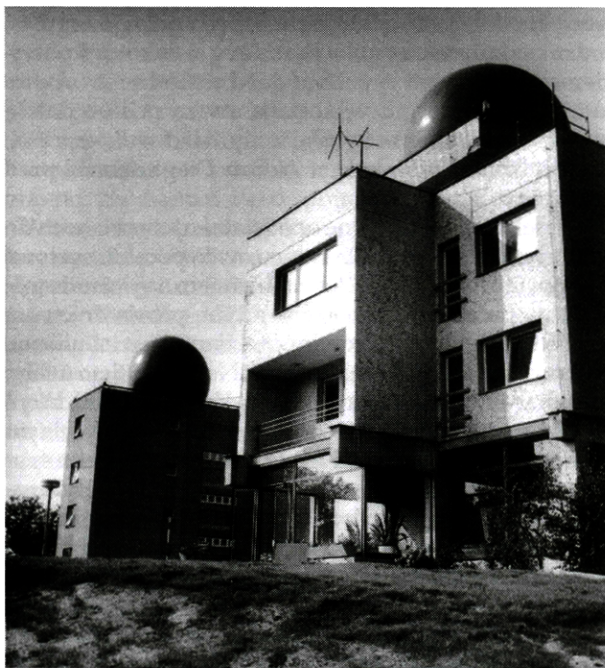
2. Rádiolokačné pracovisko SHMÚ na Malom Javorníku pri Bratislave
