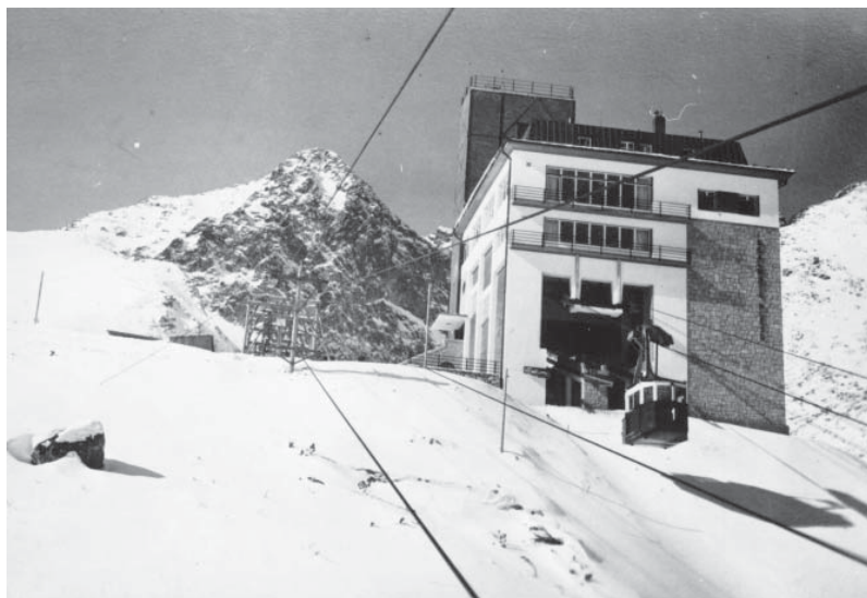
Stanica na Štrbskom plese ešte pred postavením novej sedačkovej lanovky. Foto: Slovenský národný archív, fond D. Jurkoviča
