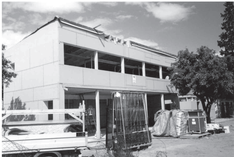
Výstavba energeticky pasívneho domu s nosnou drevenou konštrukciou a opláštením z moderných doskových prvkov na báze dreva.
