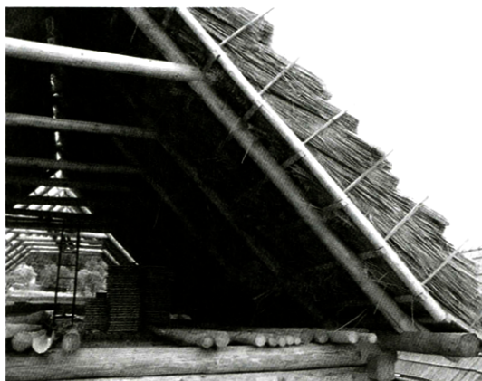
Ukončenie trstinovej časti strechy
