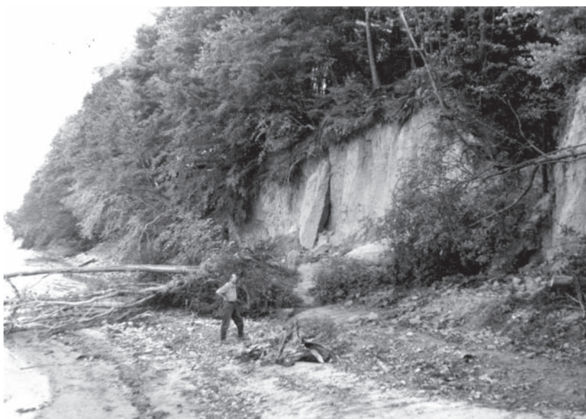
5. Abrázný zrub a abrázna plošina pri západnom okraji vodnej nádrže Veľká Domaša. Foto: R. Holzer
