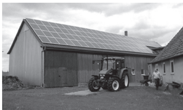
5. Fotovoltický systém pripojený do rozvodnej siete s výkonom 18 kW p (Künzell-Keulos, Nemecko). Foto: IBC Solar AG
