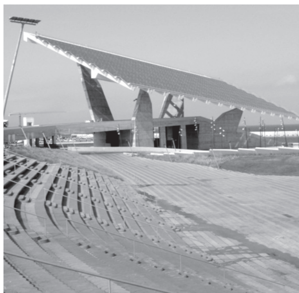
2. Fotovoltická pergola v Barcelone (Španielsko), postavená r. 2004. Nominálny výkon FV systému je 444\,kW_p s celkovou plochou FV modulov 5\,600\,m^2 . Foto: autor
