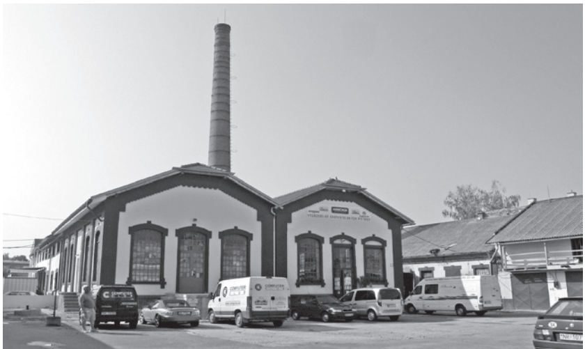
Priemyselná architektúra ACZ Nitra po rekonštrukcii a novej funkčnej náplni. Foto: R. Štěpánková
