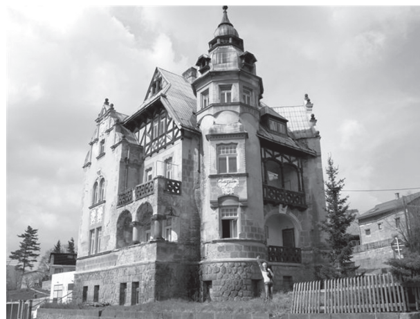
Jablonné v Podještědí – Elsnerova vila: svědek bývalé slávy a bohatství čekající na nové majitele a využití. Foto: V. Poštolka
