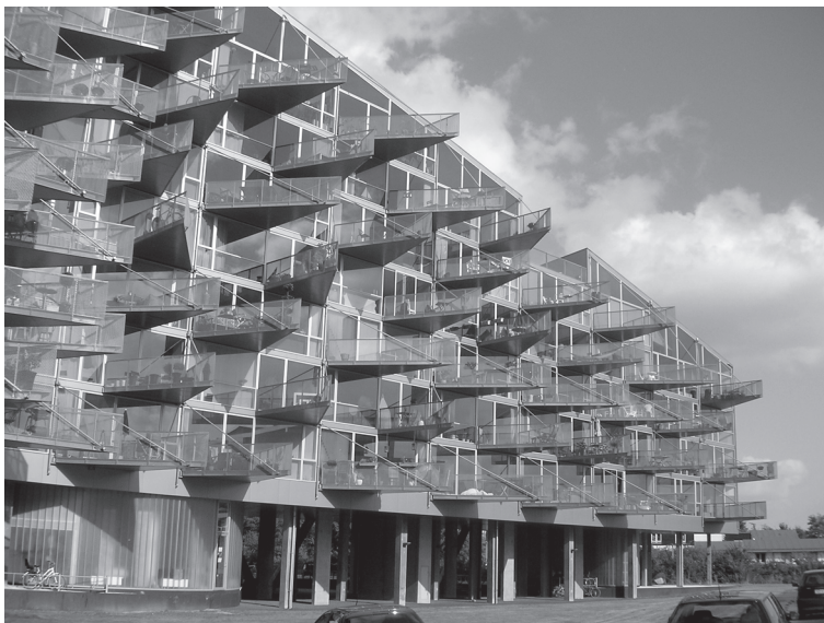
Kodaň – obytný komplex orientovaný na využitie princípu nízkoenergetických budov. Foto: M. Keppl
