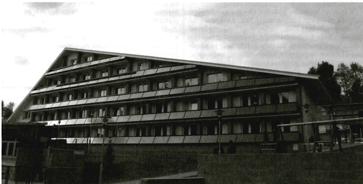
2. Slnečné kolektory na zábradliach hotela Jezerka (ČR) slúžiace na ohrev teplej vody. Foto: J. Hrádek
