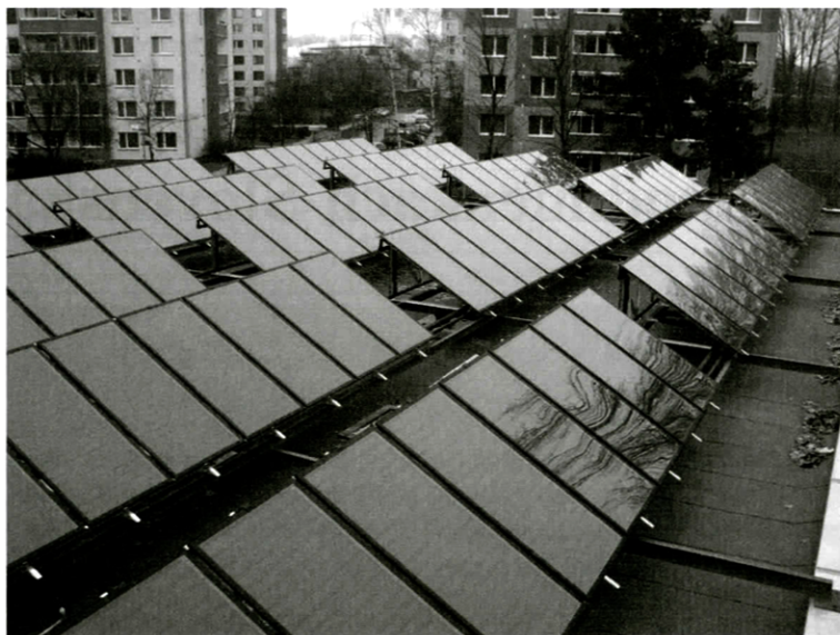
1. Stredne veľký solárny systém pre sústavu centrálného zásobovania teplom v meste Hulín v ČR. Foto: M. Procházka
