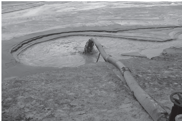
Obr. 4. Vyústenie kalovodu za korunou hrádze odkaliska Železny Most v lubinskej medenorudnej panve (Poľsko). Foto: P. Andráš, 2008
