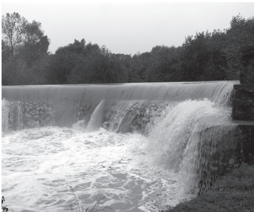
Prívalové vody sa prelievajú cez oporný múr záchytnej vodnej nádrže (obec Smrečany, okres Liptovský Mikuláš). Foto: T. Hrnčiarová
