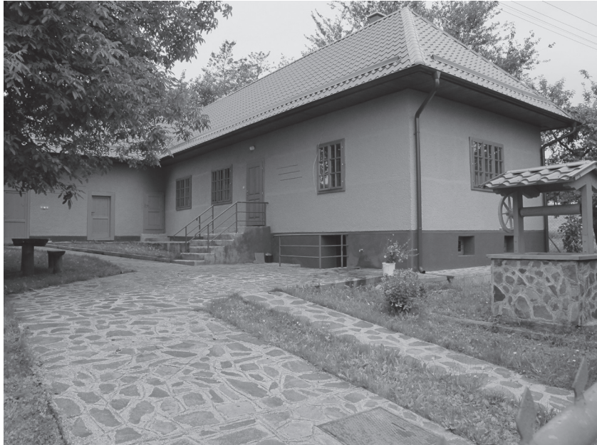
Obr. 1. Funkčne dotvorené nádvorie chalupy z pôvodného gazdovského domu na lazoch (Veľká Lehota, 2012). Foto: Ján Supuka
