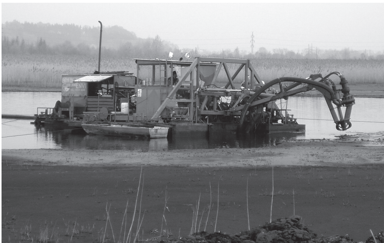
Obr. 2. Sací bagr pro odstraňování sedimentů, Odkaliště Dolu Darkov (2005). Foto: Jan Kucharčík
