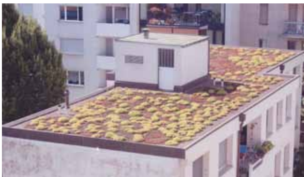
Obr. 1. Příklad extenzivní, nepobytové, veřejnosti nepřístupné zelené střechy (bytový dům, Bazilej, Švýcarsko, 2012). Foto: Milada Baumannová
