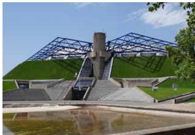
Obr. 2. Vegetační střechy – součást architektonického řešení objektu (Palác různých sportů Paříž-Bercy, 2013). Foto: Milada Baumannová
