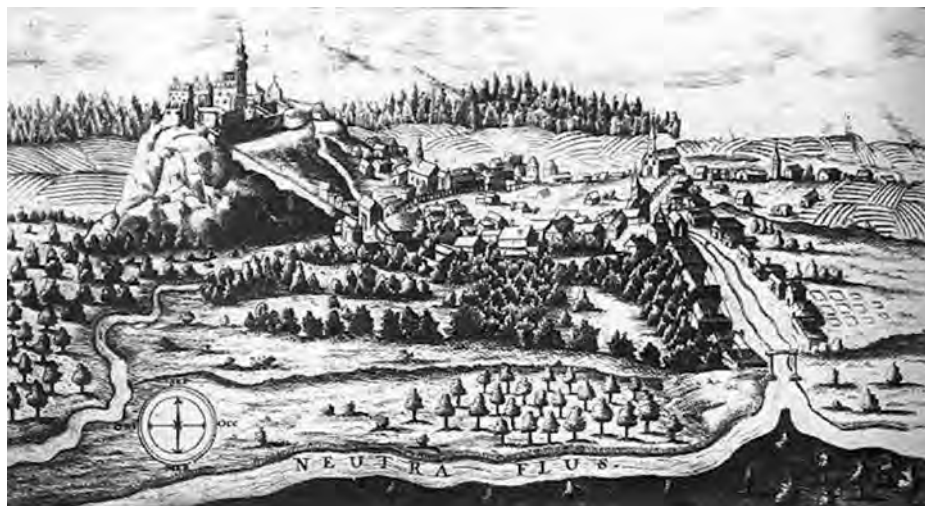
Obr. 1. Historická časť mesta Nitra zobrazená na dobovej medirytine L. Schnitzera z roku 1664. Rieka Nitra je zobrazená ako výrazný mestotvorný prvok. Zdroj: http://www.oocities.org/thetropics/lagoon/1814/rytiny.html
