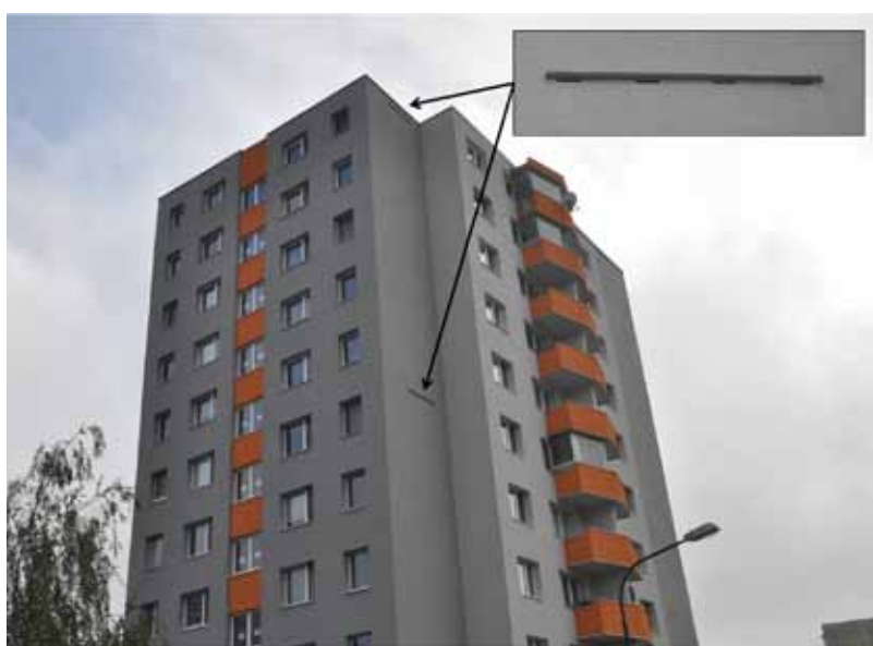
Obr. 5. Búdky pre netopiere nainštalované na Veternicovej 2 – mestská časť Karlova Ves (Bratislava, 2014). Foto: Blanka Lehotská
