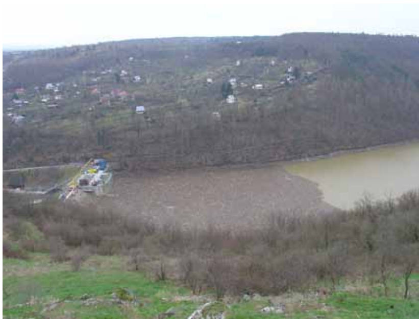
Obr. 2. Dřevní hmota naplavená k hrázi vodního díla Znojmo při povodni v březnu/dubnu 2006. Foto: Pavel Kožený
