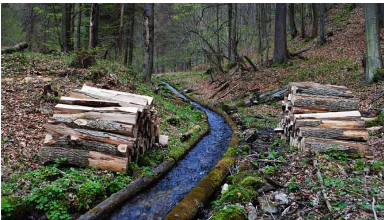
Obr. 3. Rovnané drevo nachystané na splavenie dreveným vodným žľabom v lokalite Dolný Zinzolen (apríl 2015). Foto: Eduard Apfel
